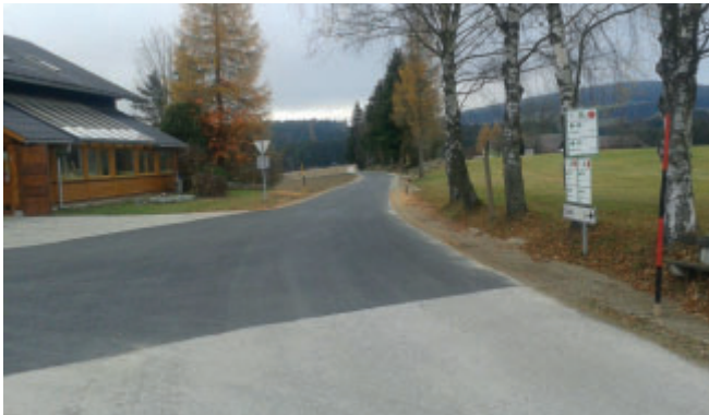
Instandsetzung des Güterweges Pürstling
