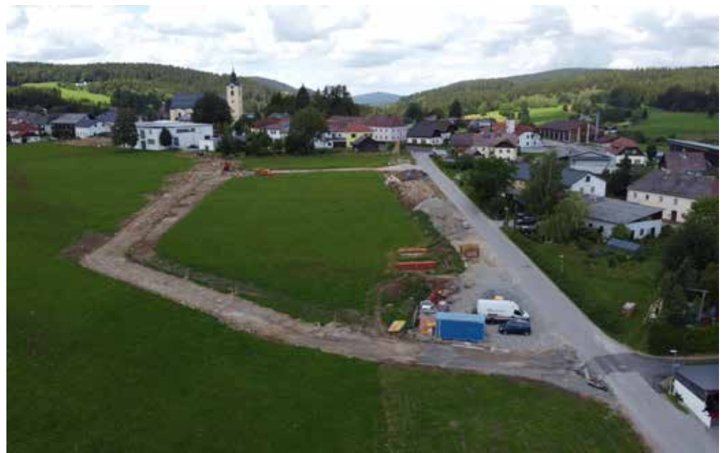
Bei den Baugründen der Staubersiedlung geht die Aufschließung zügig voran
