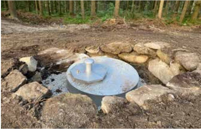
Erneuerung Quellsammelschacht Viehberg
