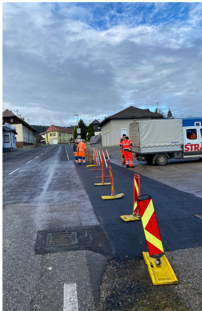
Neuer Gehsteig entlang der „alten Tankstelle“
