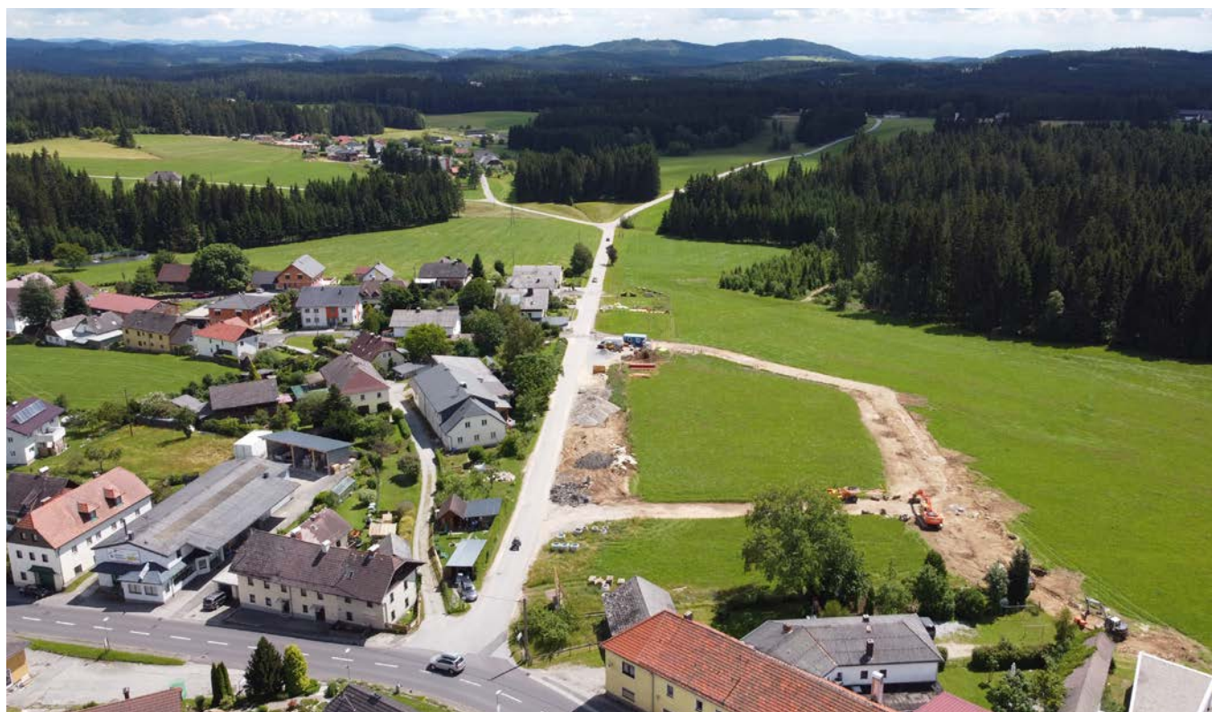
Fast alle 13 Bauparzellen in der Ausiedlung sind schon verkauft.
