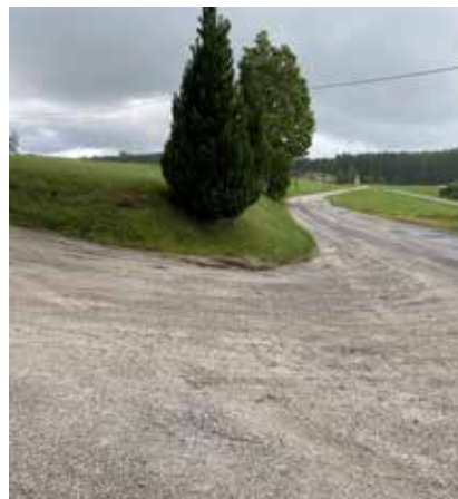
Beim Güterweg Spörbichl werden die Arbeiten beginnen
