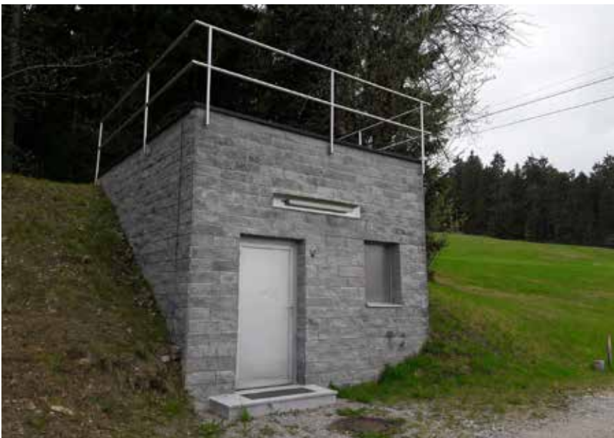
Notversorgung durch den Hochzonenbehälter wird sichergestellt
