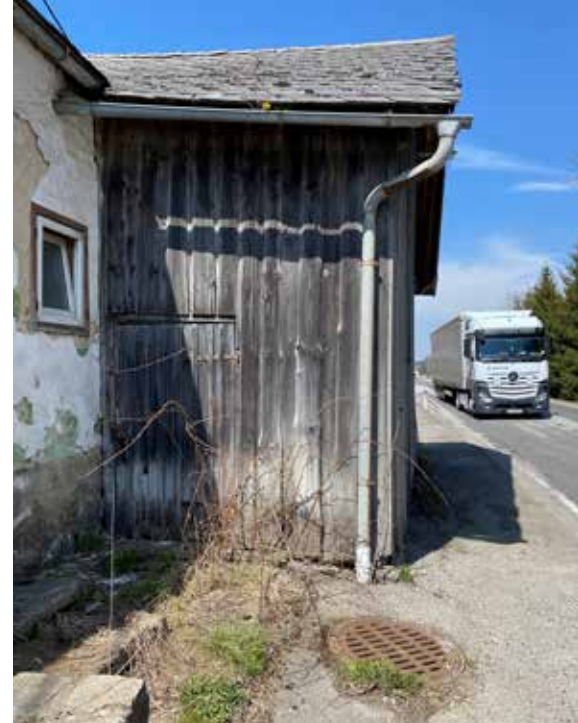
Gehweg entlang der B38 wird asphaltiert
