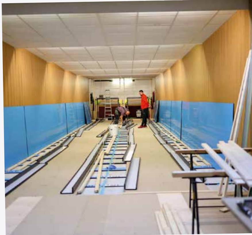
Baufortschritt bei der Errichtung der neuen Kegelbahnen
