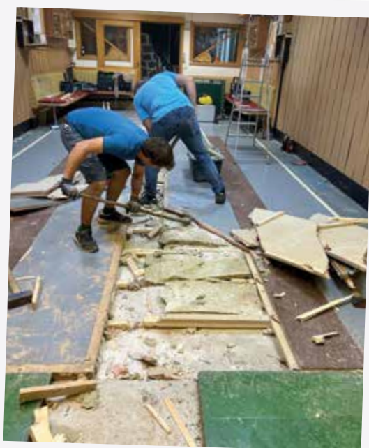
Beginn der Bauarbeiten
